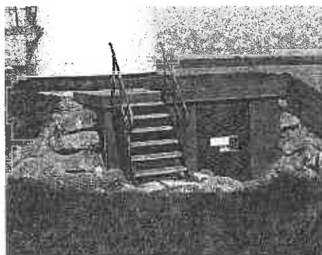
Vue du transformateur intégré aux fondations recouvertes d'un tumulus enherbé (photo CE)
